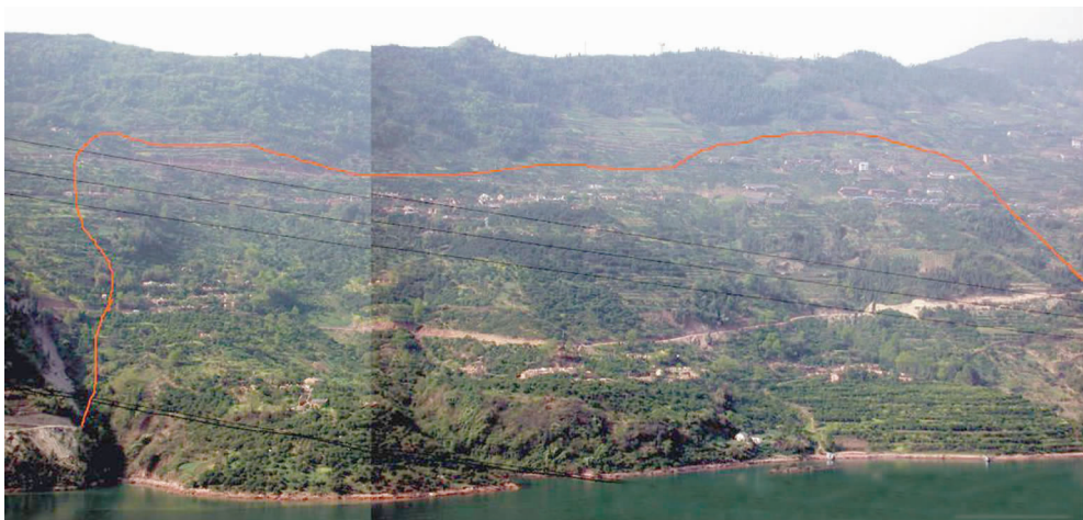
图 6 树坪滑坡体全貌
