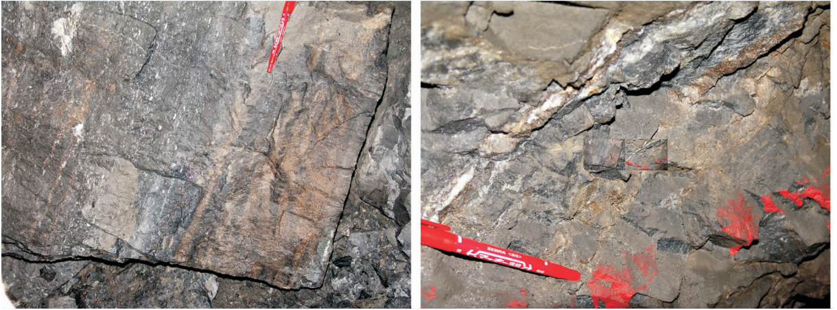
图 3 跑马铅锌矿坑道中铅锌矿体 Fig.3 Pb-Zn ore body of the Paoma deposit
