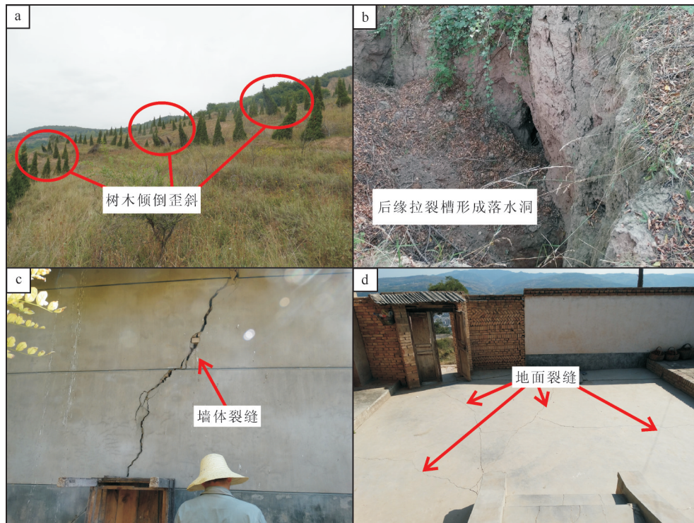
图8 红旗山滑坡现今变形破坏现象
