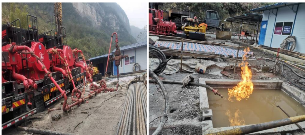
图 9 RX1 井压裂现场及点火照片
