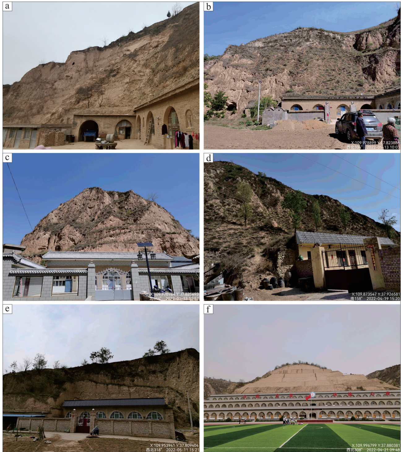
图8 野外判断斜坡危险程度典型斜坡段
