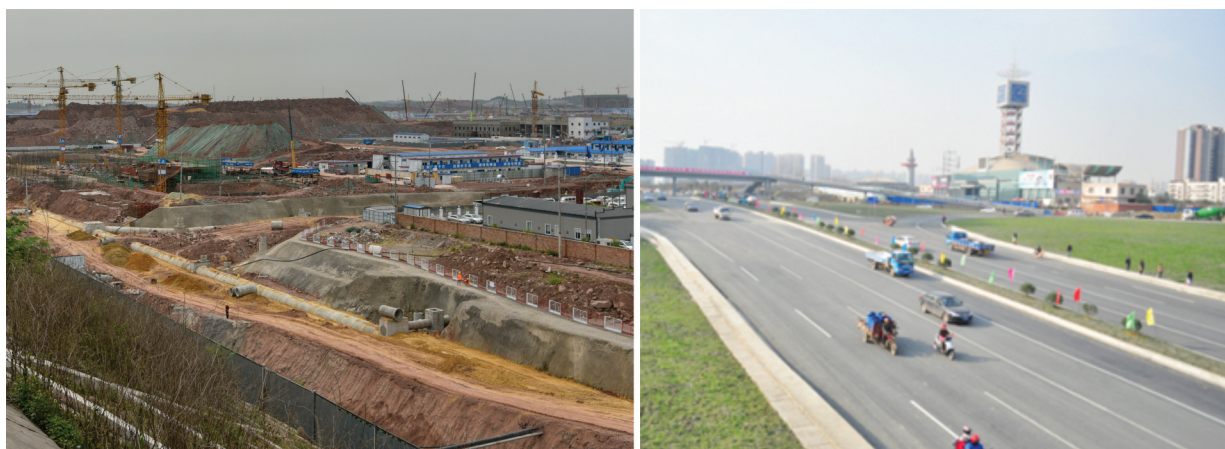
图6 试验点三现场工况
