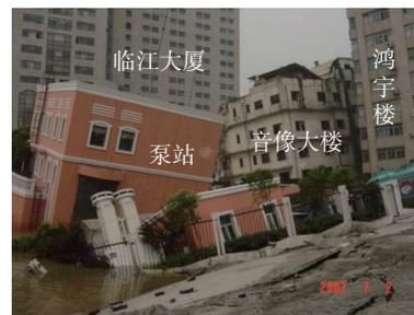
图 6 陷坑致泵站、音像大楼与鸿宇楼倾斜
