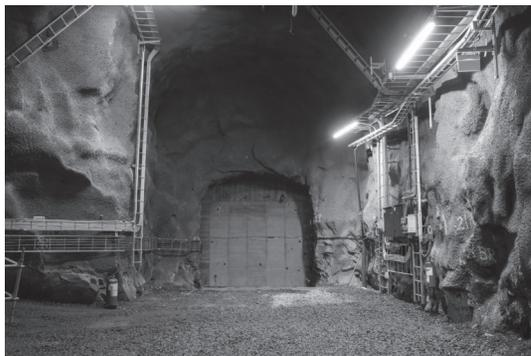
图 7 Hybrit 项目储氢衬砌岩洞
